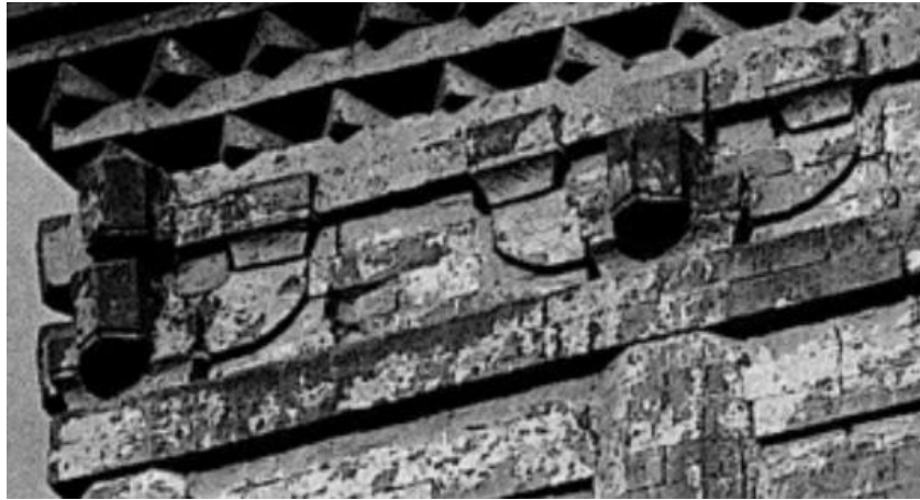
5、牛头卷葷 (jú): 包括牛头砖卷葷 (jú)、牛头砖覆背和条砖缴背。
